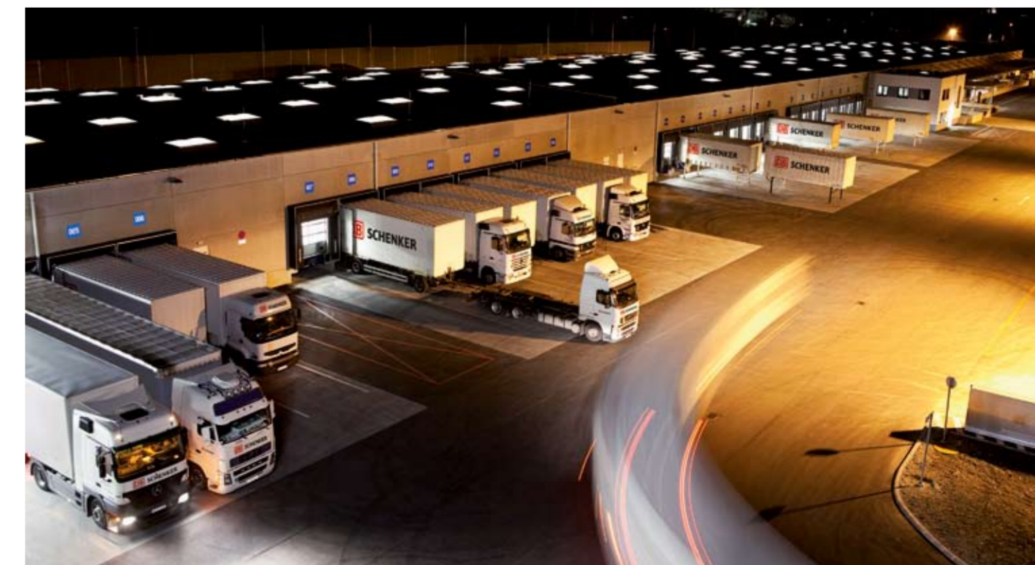
Der neue Terminal in Salzburg bietet Lösungsvielfalt in einer neuen Dimension. Foto: Fotografie Neuhaus
